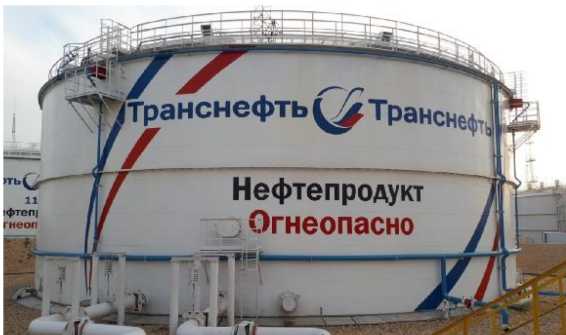
Рисунок 2 – Общий вид резервуаров РВСП-10000 зав.№№ 12, 15, 16
