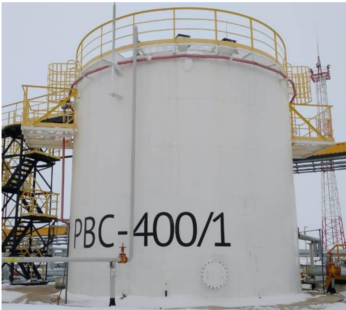
Рисунок 1 – Резервуар вертикальный стальной цилиндрический РВС-400
