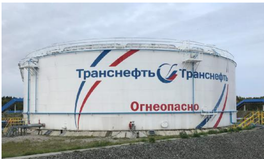
Рисунок 1 – Общий вид резервуаров РВСП-20000 зав.№№ 11, 12
