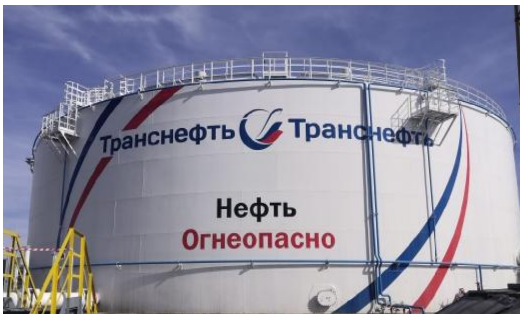
Рисунок 2 – Общий вид резервуаров РВСП-20000 зав.№№ 1, 4
