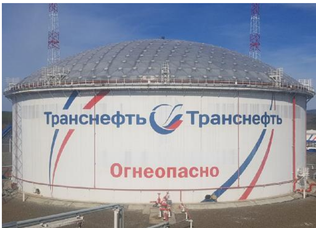
Рисунок 1 – Общий вид резервуаров РВСПА-50000 зав.№№ 2, 3, 4, 5, 6
