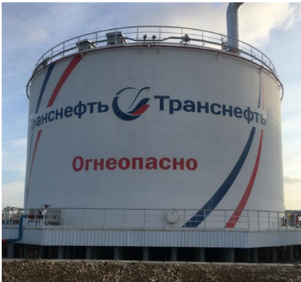
Рисунок 3 - Общий вид резервуара РВС-5000 зав.№№ 1, 2, 101, 102
