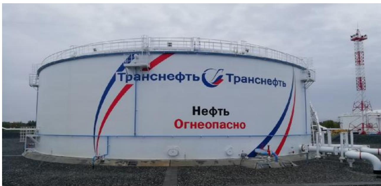
Рисунок 1 – Общий вид резервуаров РВСП-20000 зав.№№ 2, 4, 8, 10, 12, 20
