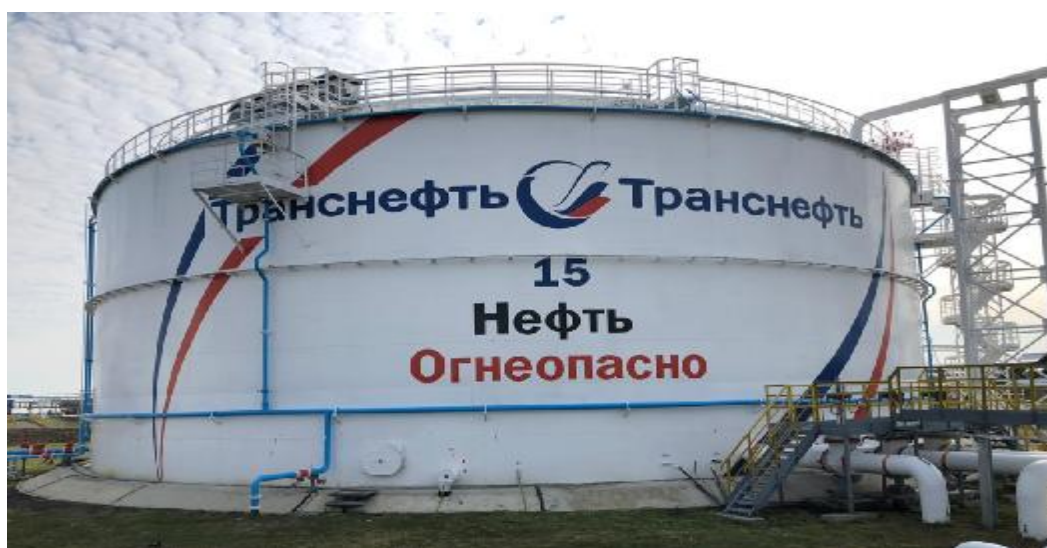
Рисунок 1 – Общий вид резервуара РВС-10000 зав.№ 15
