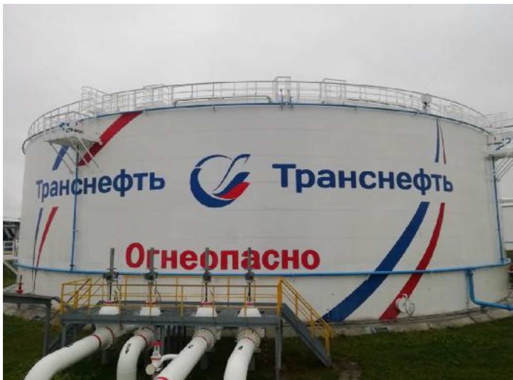
Рисунок 4 – Общий вид резервуаров РВСП-20000 зав.№№ 21, 36, 37
