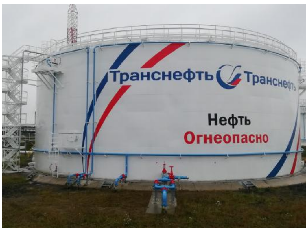
Рисунок 3 – Общий вид резервуаров РВСП-10000 зав.№№ 2, 9, 11, 14
