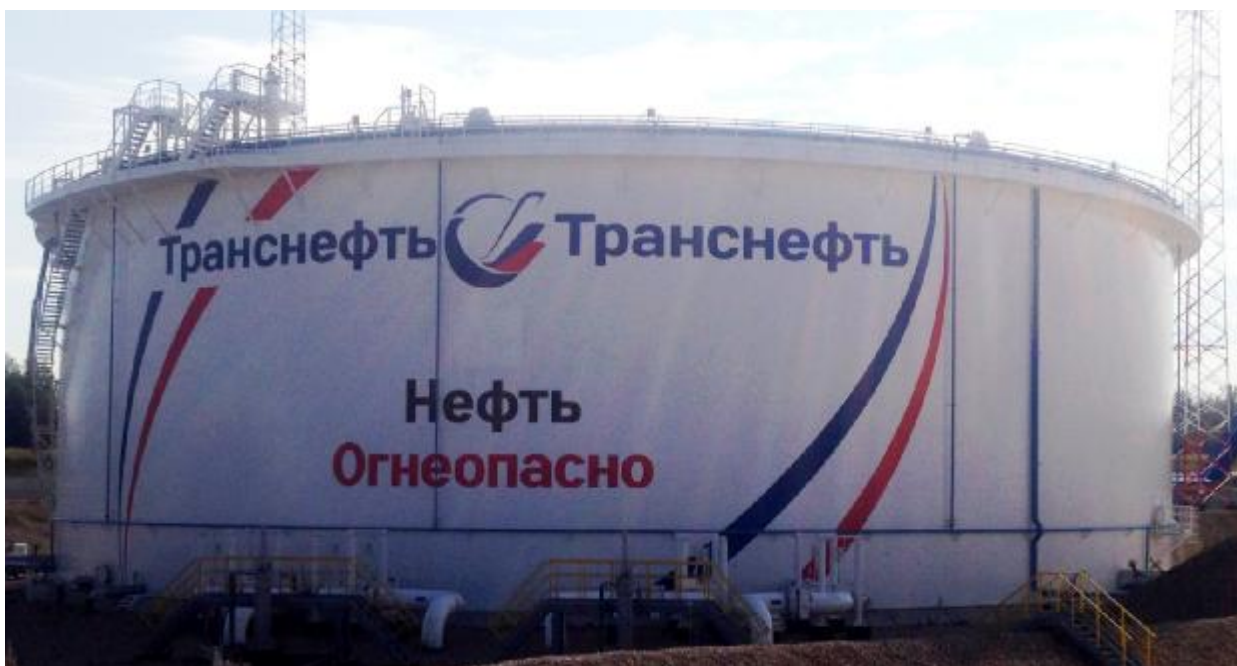
Рисунок 1 – Общий вид резервуаров РВСПК-50000 зав.№№ 9, 10, 12
