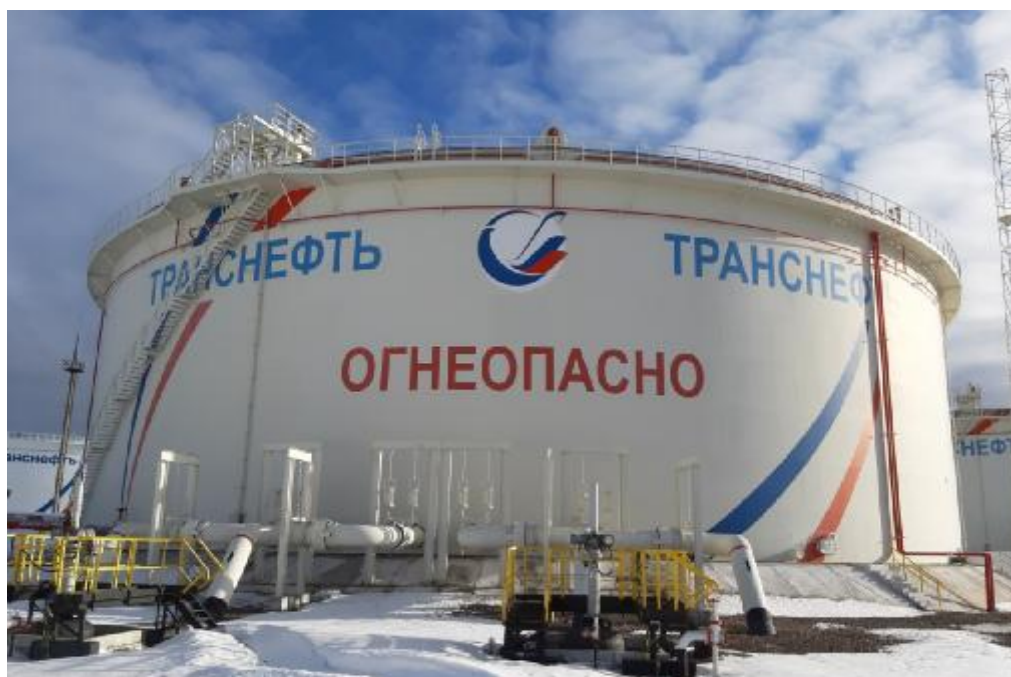
Рисунок 1 – Общий вид резервуаров РВСПК-50000 зав.№№ 13, 14, 18
