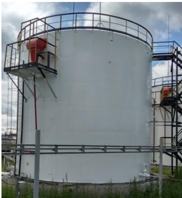
Рисунок 1 – Общий вид резервуаров стальных вертикальных цилиндрических РВСП-700
