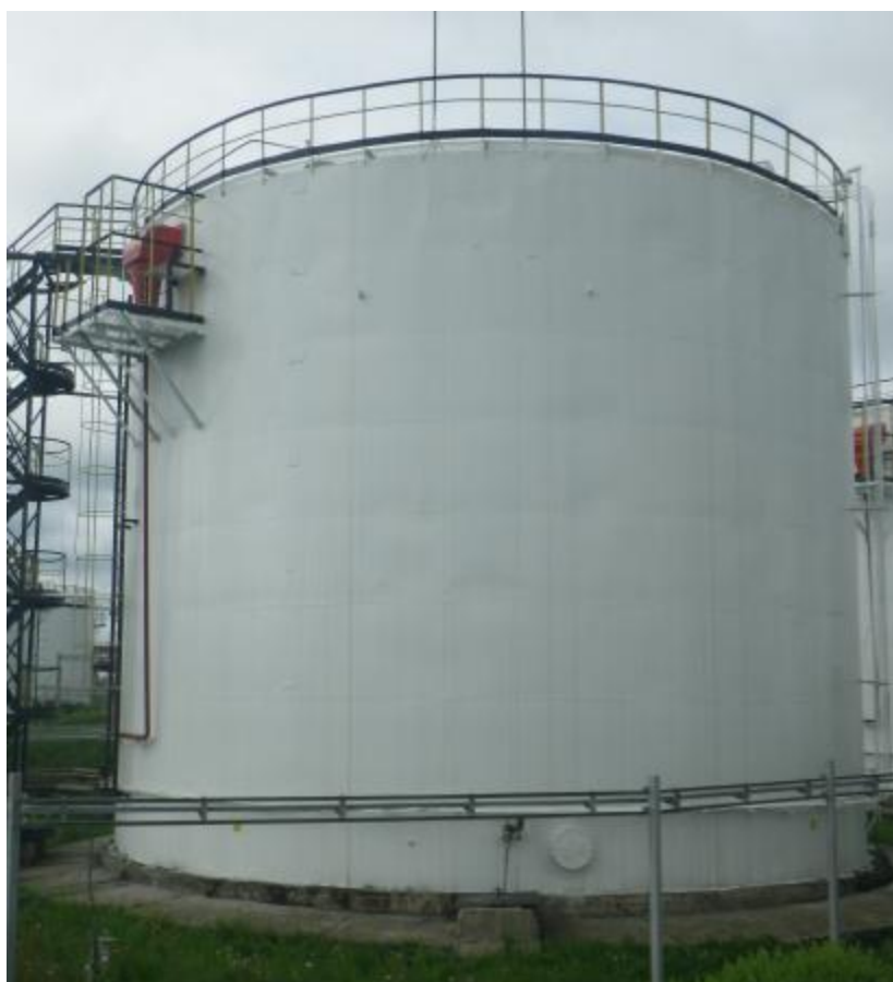
Рисунок 3 – Общий вид резервуаров стальных вертикальных цилиндрических РВСП-2000
