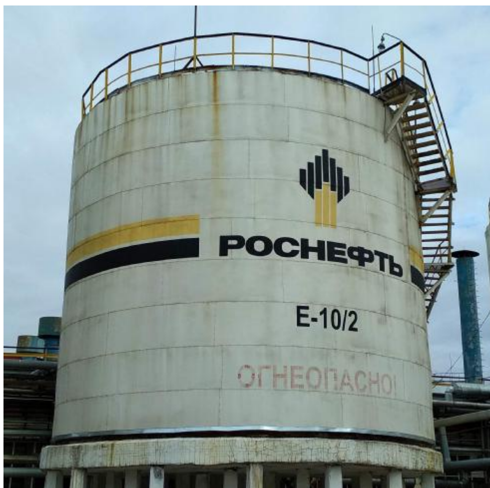
Рисунок 2 – Общий вид резервуаров стальных вертикальных цилиндрических РВС-700
