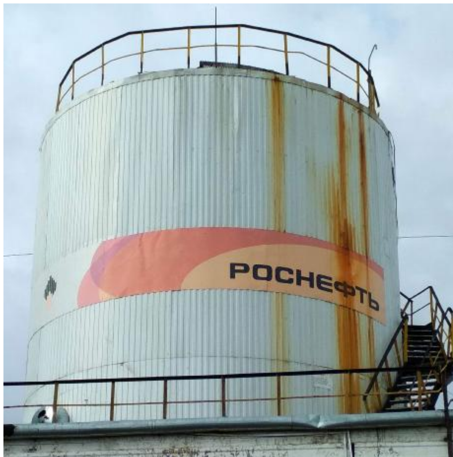
Рисунок 1 – Общий вид резервуаров стальных вертикальных цилиндрических РВС-300
