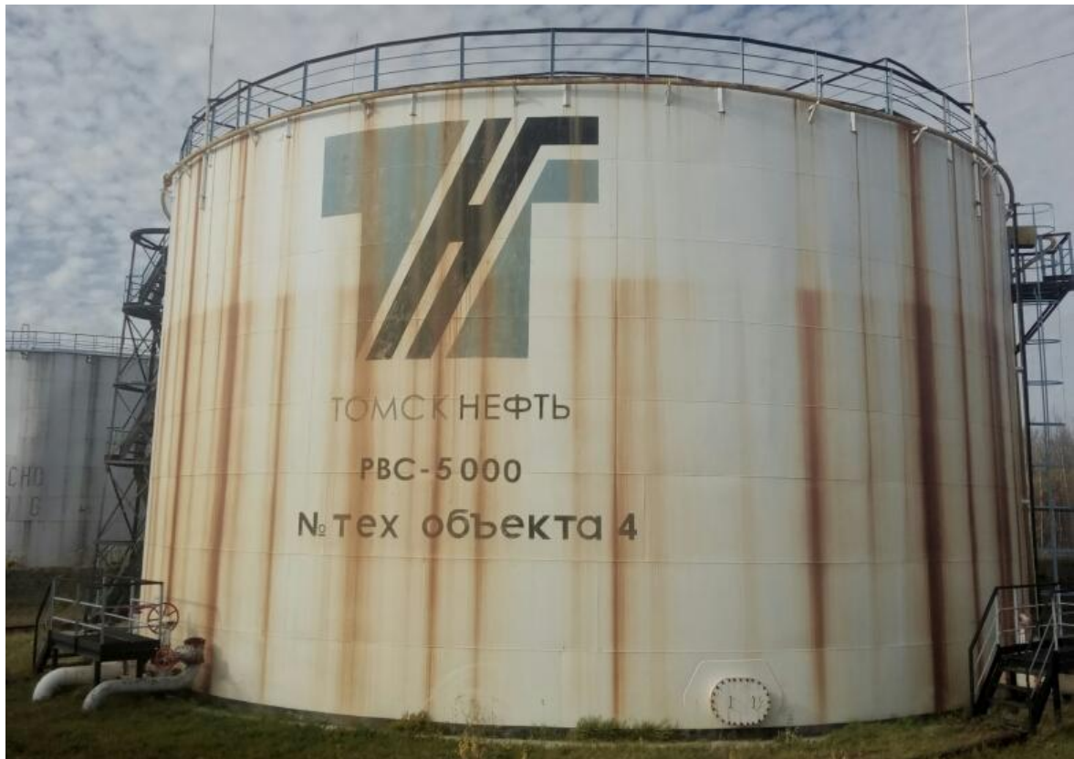
Рисунок 1 – Общий вид резервуара РВС-5000
