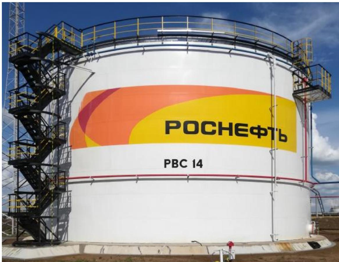
Рисунок 2 – Общий вид резервуаров стальных вертикальных цилиндрических PBC-5000
