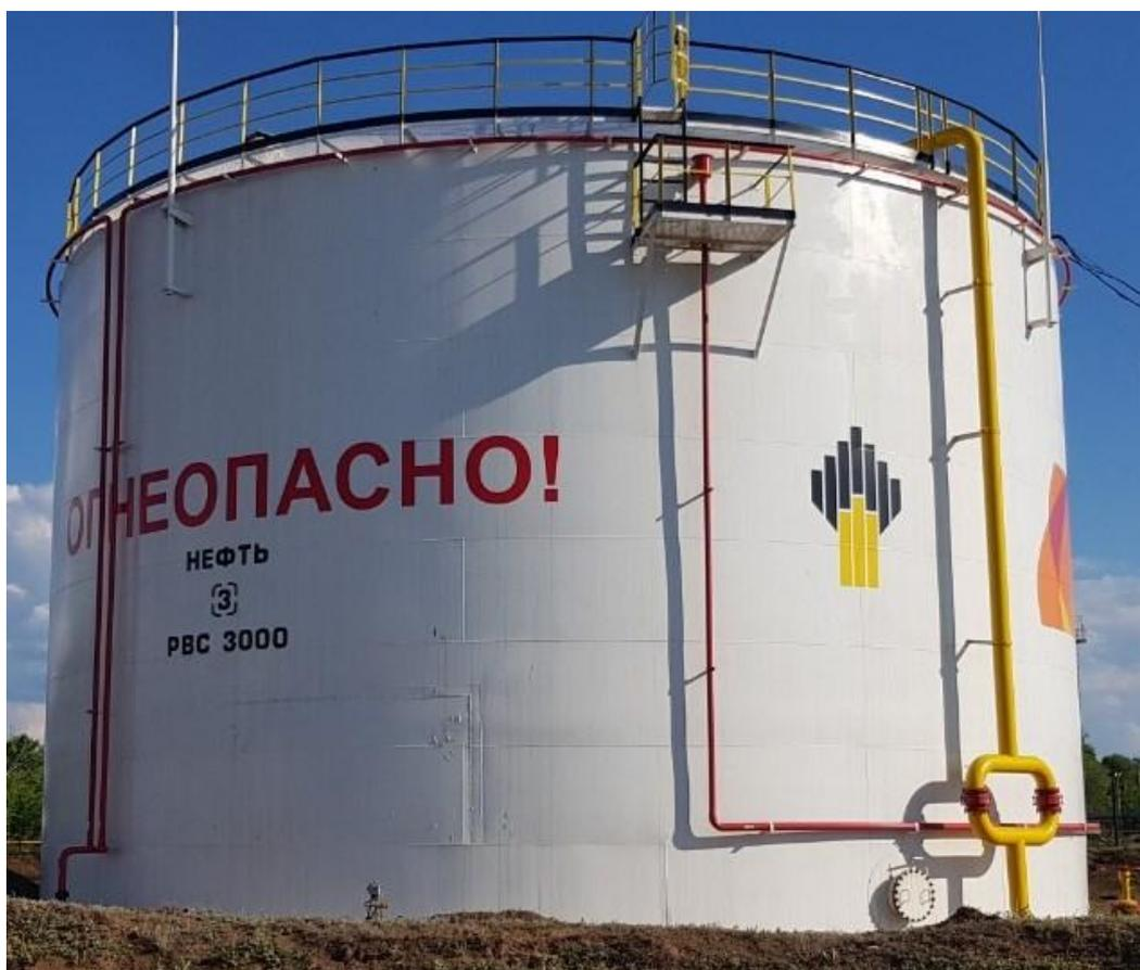
Рисунок 1 – Общий вид резервуара стального вертикального цилиндрического РВС-3000
