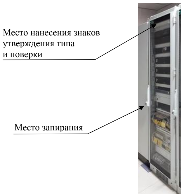
Рисунок 17 – Места расположения знаков утверждения типа и поверки и запираания стойки приборной АИИС
