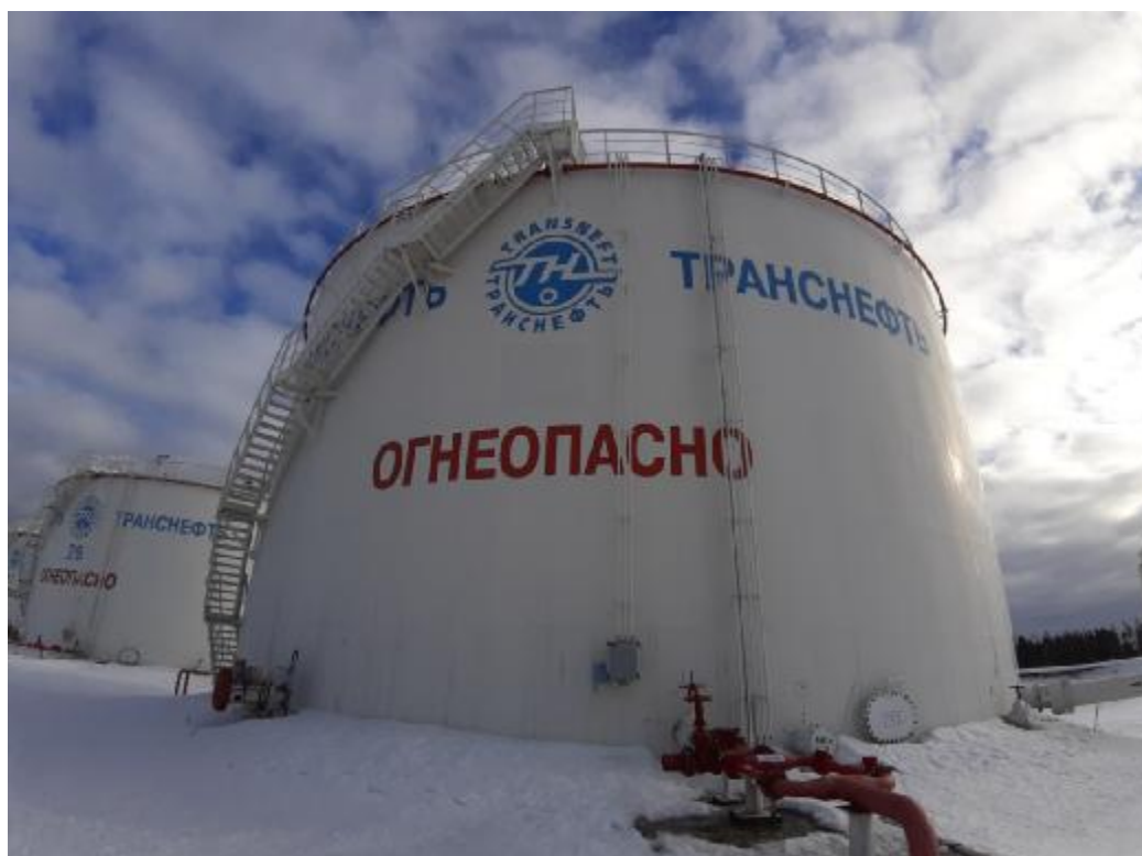
Рисунок 1 – Общий вид резервуаров РВС-5000 зав.№№ 27, 28, 29
