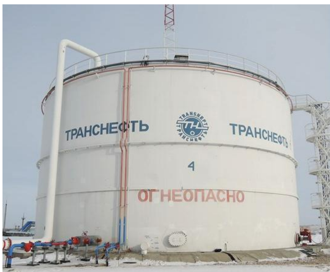
Рисунок 2 – Общий вид резервуара РВС-5000 зав.№ 4
