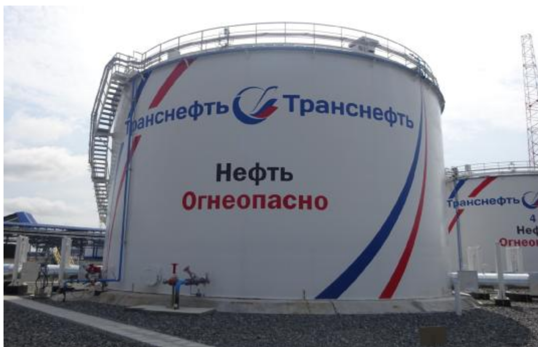
Рисунок 1 – Общий вид резервуаров РВС-5000 зав.№№ 3, 4
