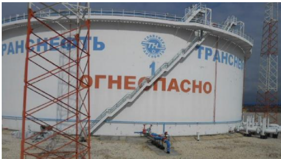
Рисунок 1 – Общий вид резервуара РВСПК-50000 зав.№ 1
