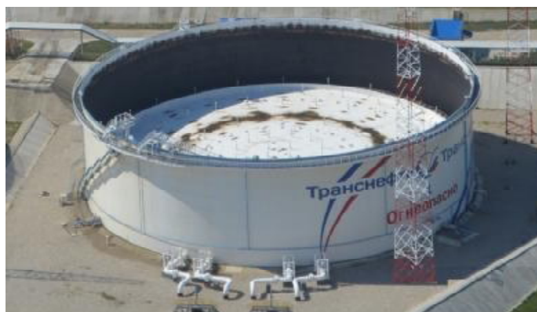
Рисунок 1 – Общий вид резервуаров РВСПК-50000 зав.№№ 1, 3
