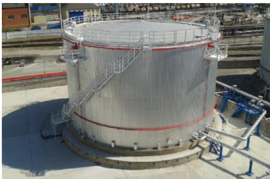
Рисунок 1 – Общий вид резервуара РВС-5000
