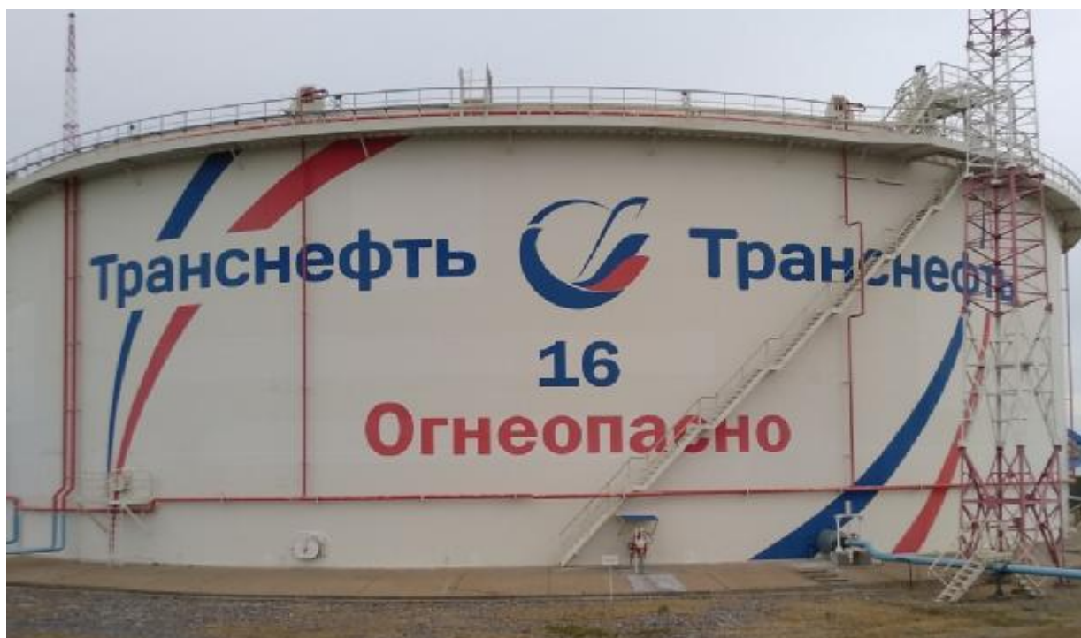
Рисунок 1 – Общий вид резервуара РВСПК-50000 зав.№ 16
