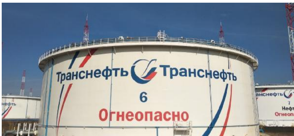
Рисунок 1 – Общий вид резервуара РВСПК-50000 зав № 6
