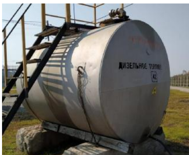
Рисунок 3 – Общий вид резервуара стального горизонтального цилиндрического РГС-10 № 42
