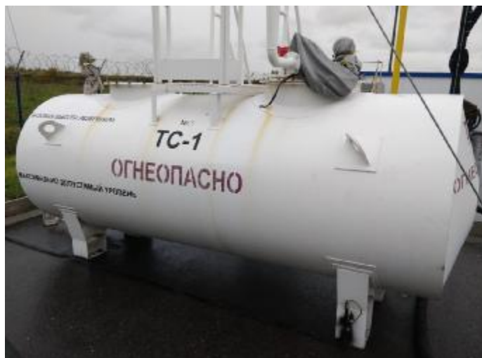
Рисунок 1 – Общий вид резервуара стального горизонтального цилиндрического РГС-5
