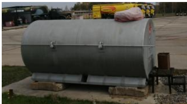
Рисунок 1 – Общий вид резервуаров стальных горизонтальных цилиндрических РГС-4
