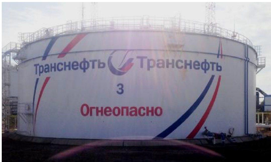
Рисунок 3 – Общий вид резервуара РВСП-20000 зав.№ 3
