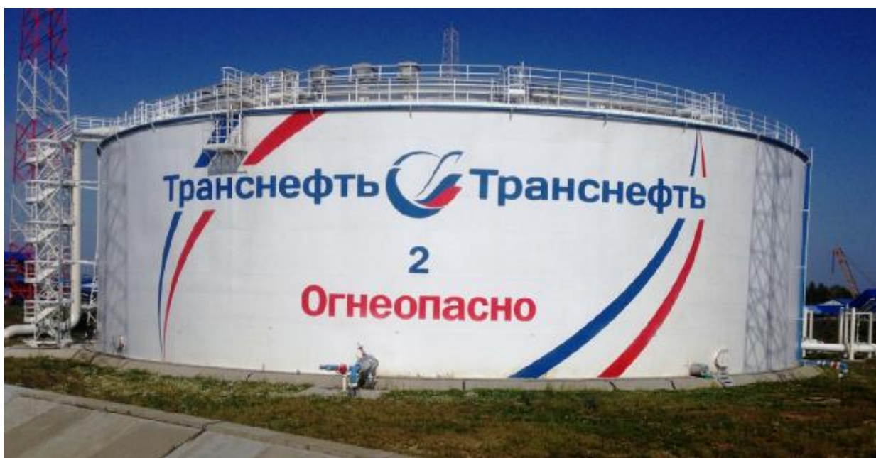
Рисунок 2 – Общий вид резервуара РВС-20000 зав.№ 2
