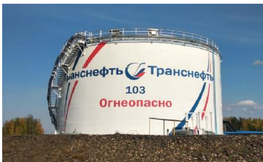
Рисунок 2 – Общий вид резервуара РВС-5000 зав.№ 103
