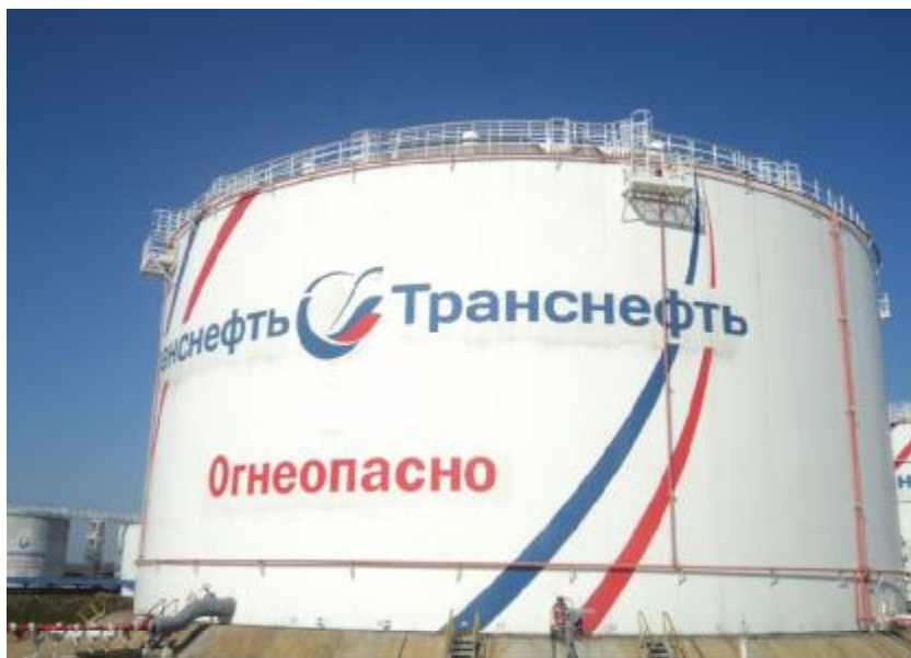
Рисунок 1 – Общий вид резервуаров РВСП-20000 зав.№№ 1, 2
