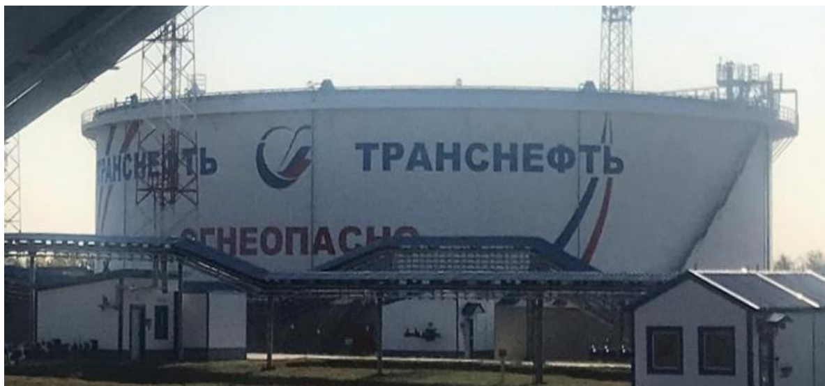
Рисунок 1 – Общий вид резервуаров РВСПК-50000 зав.№№ 21, 22
