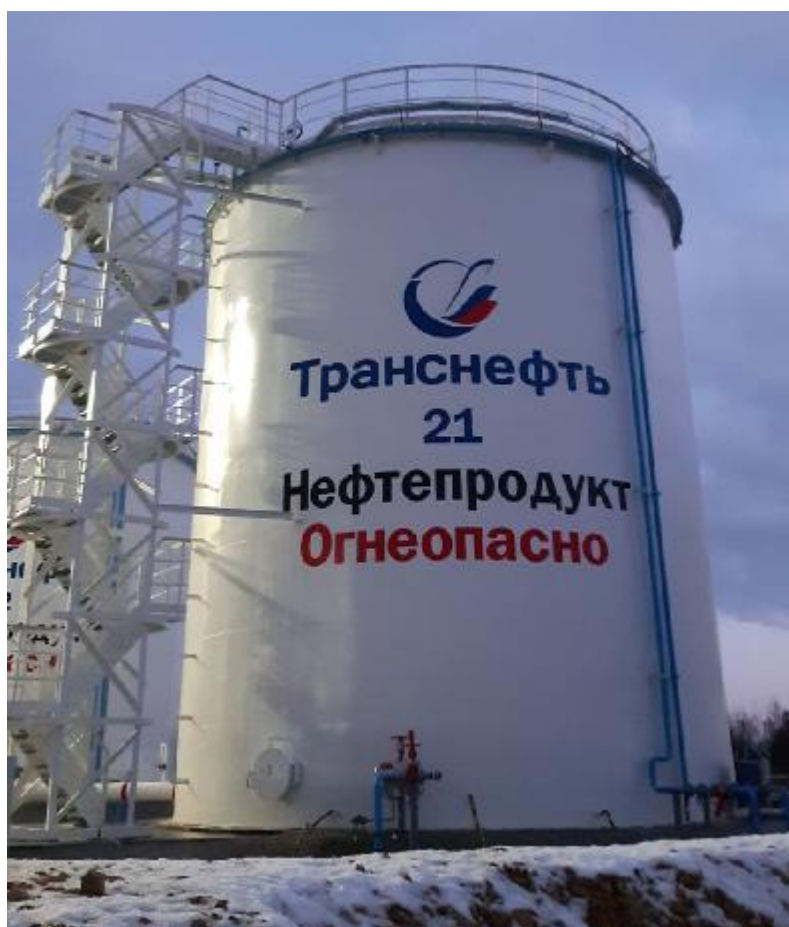
Рисунок 1 – Общий вид резервуара РВС-1000
