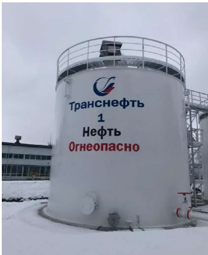
Рисунок 1 – Общий вид резервуара РВС-400
