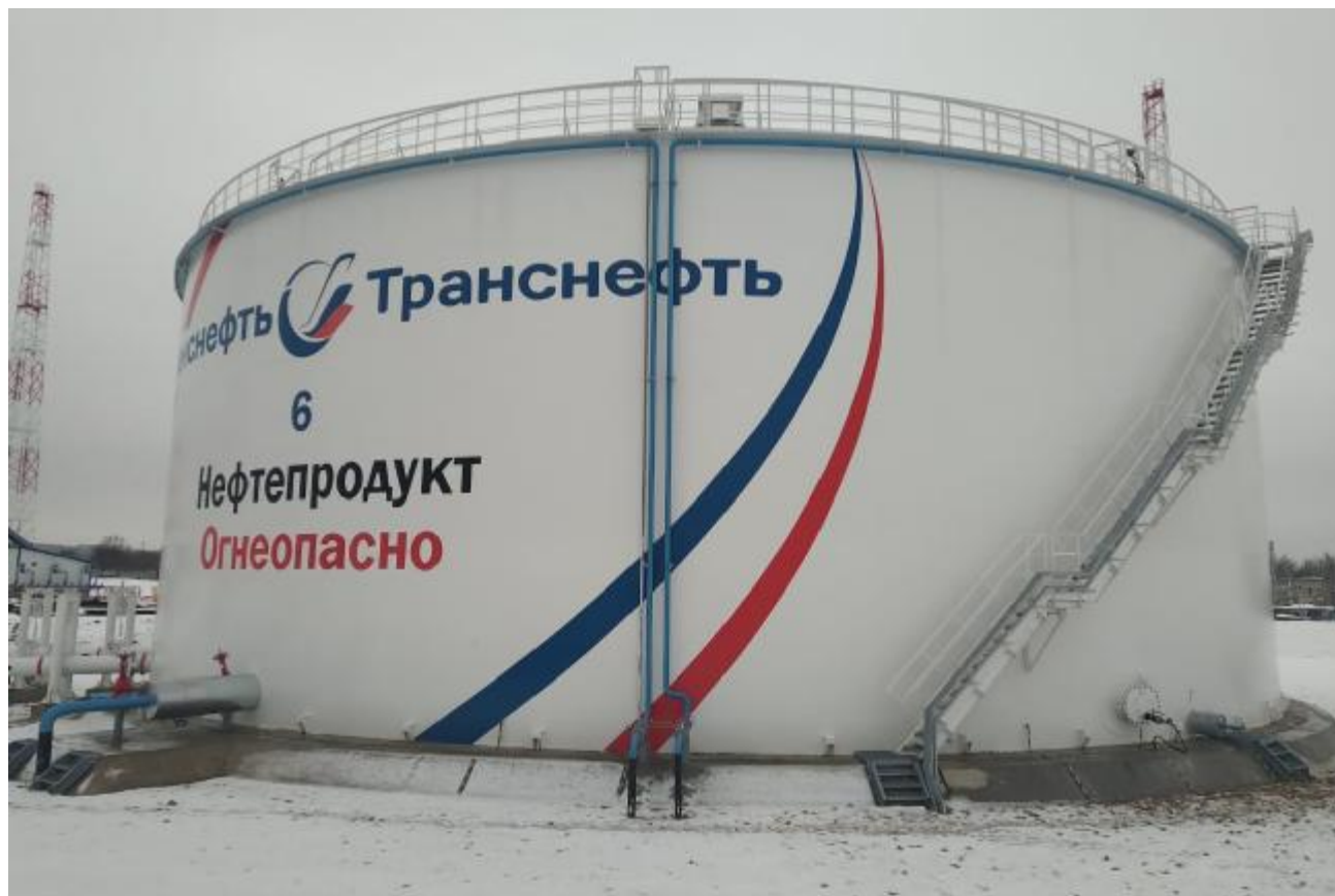
Рисунок 1 – Общий вид резервуара РВС-10000 № 6
