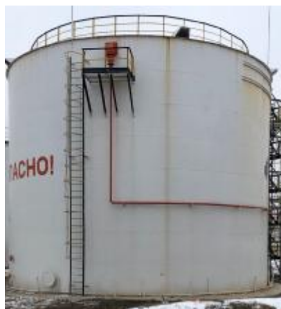
Рисунок 4 – Общий вид резервуаров стальных вертикальных цилиндрических РВСП-2000
