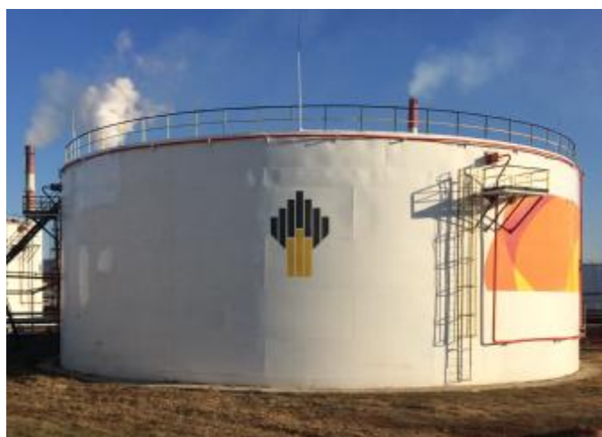
Рисунок 9 – Общий вид резервуаров стальных вертикальных цилиндрических РВС-8000
