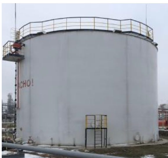
Рисунок 6 – Общий вид резервуаров стальных вертикальных цилиндрических РВСП-3000
