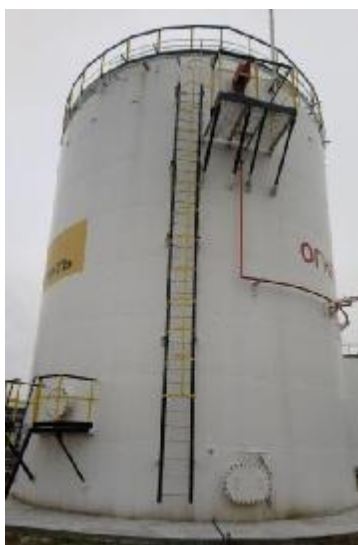
Рисунок 1 – Общий вид резервуаров стальных вертикальных цилиндрических РВС-1000
