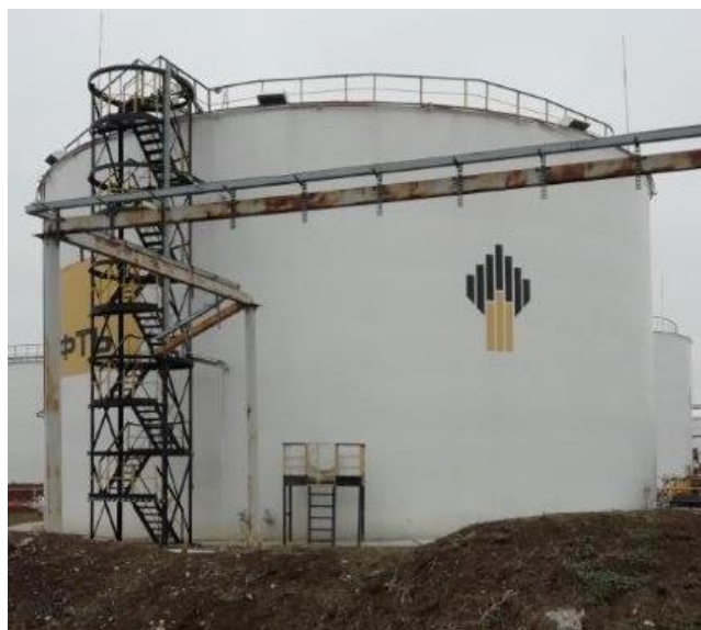
Рисунок 8 – Общий вид резервуаров стальных вертикальных цилиндрических РВСП-5000
