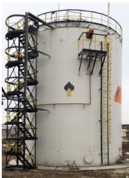
Рисунок 2 – Общий вид резервуаров стальных вертикальных цилиндрических РВСП-1000
