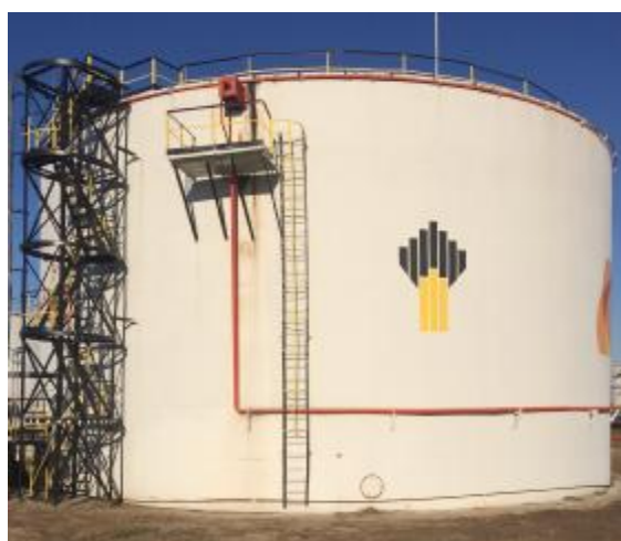
Рисунок 7 – Общий вид резервуаров стальных вертикальных цилиндрических РВС-5000
