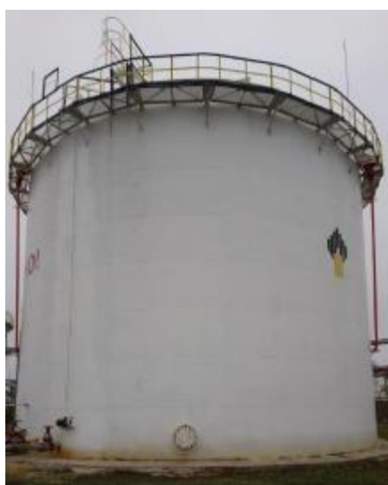
Рисунок 3 – Общий вид резервуаров стальных вертикальных цилиндрических РВС-2000
