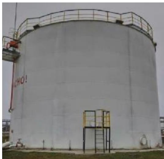
Рисунок 5 – Общий вид резервуаров стальных вертикальных цилиндрических РВС-3000
