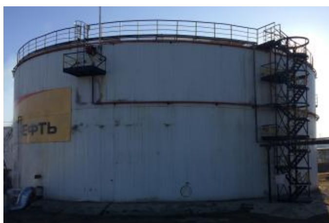
Рисунок 10 – Общий вид резервуаров стальных вертикальных цилиндрических РВС-10000
