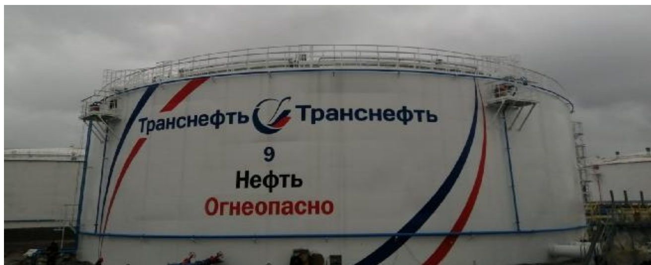
Рисунок 1 – Общий вид резервуара вертикального стального цилиндрического РВСП-20000, заводской номер 9
