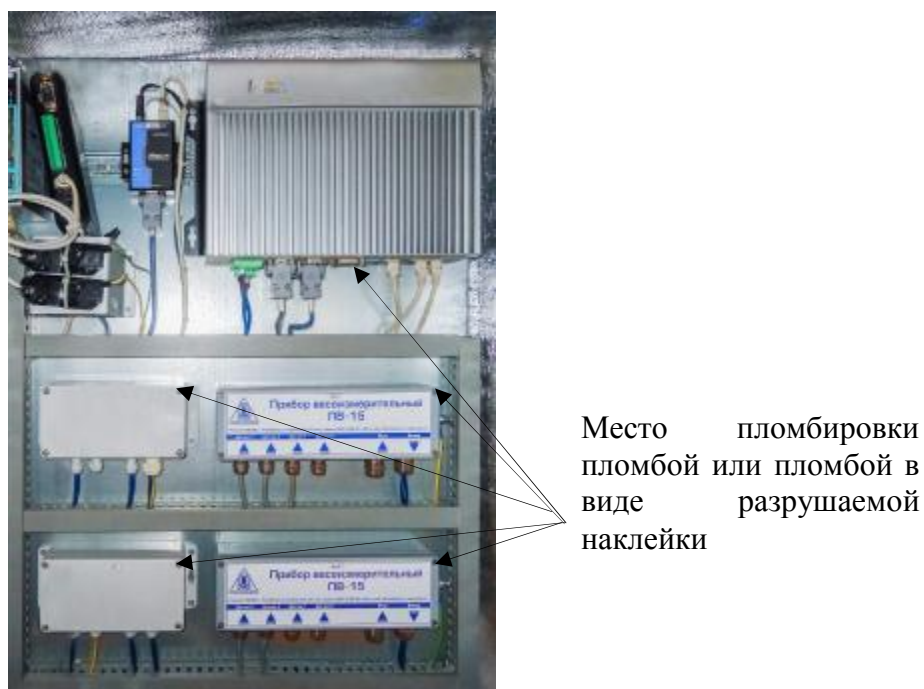
Рисунок 3 – Схема пломбировки от несанкционированного доступа
