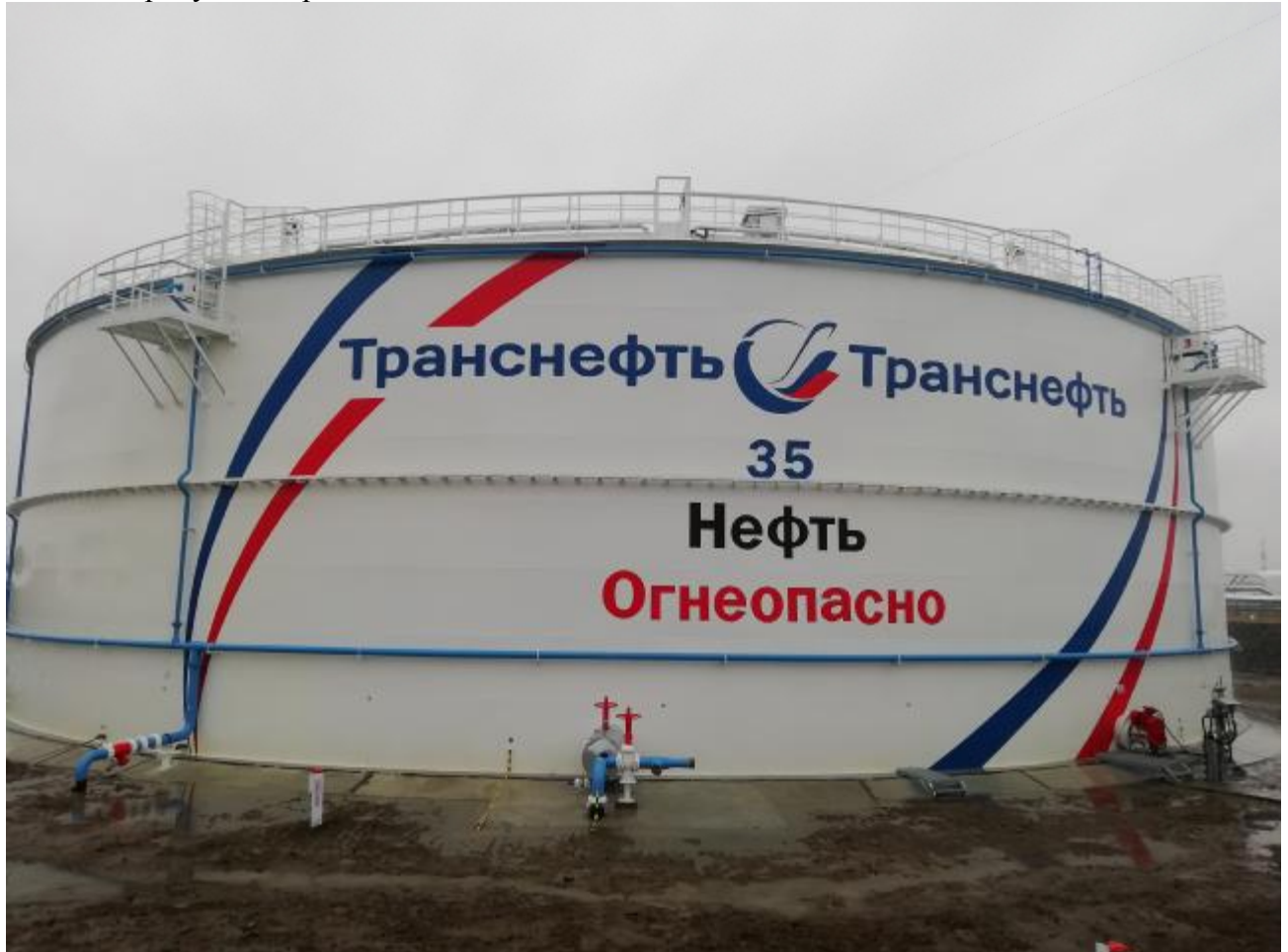
Рисунок 1 – Общий вид резервуара вертикального стального цилиндрического РВС-20000, заводской номер 35
