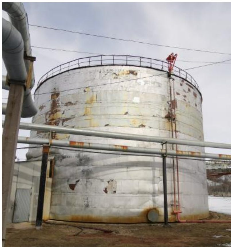
Рисунок 1 – Общий вид резервуаров РВС-3000
