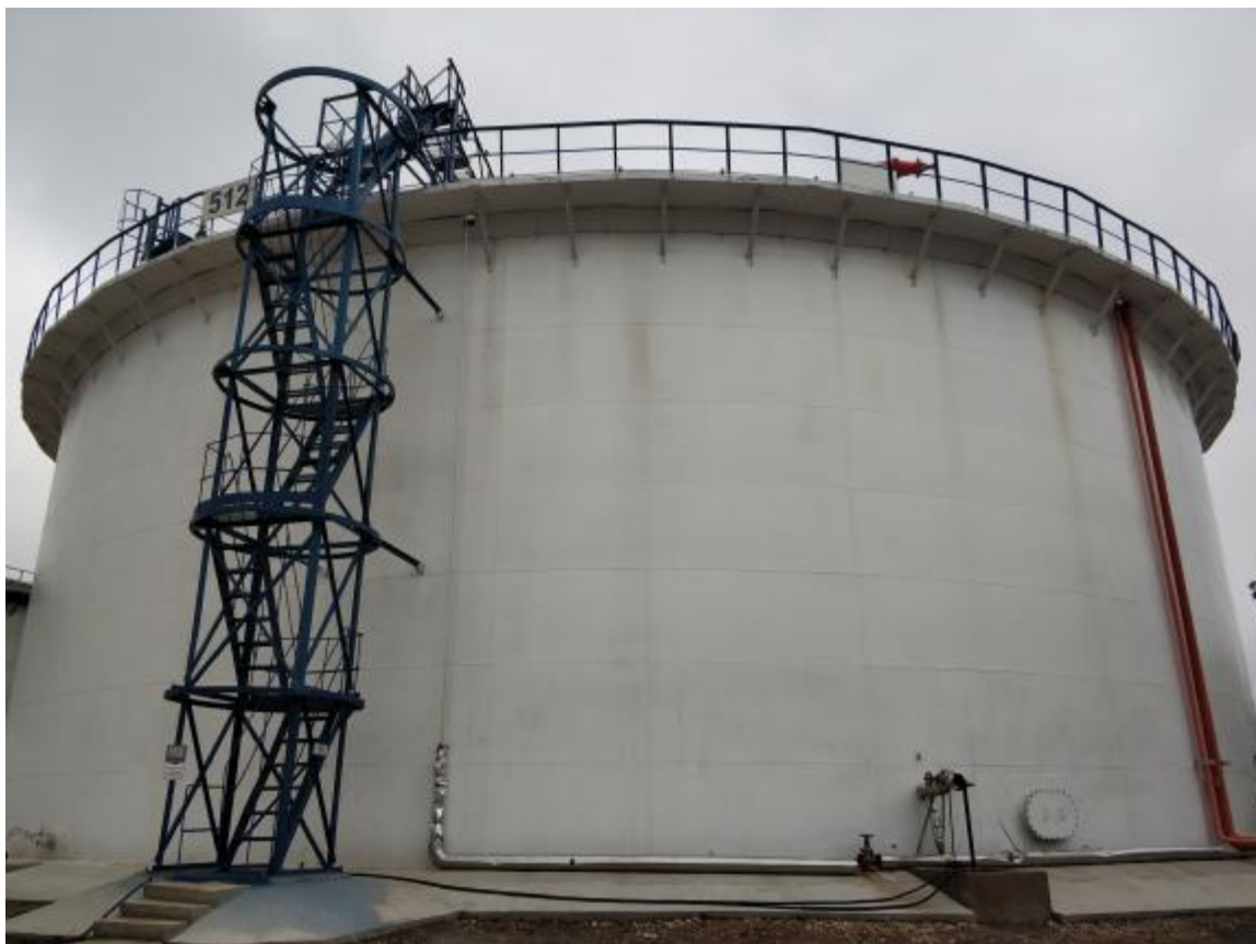
Рисунок 1 – Общий вид резервуара РВСПК-10000
