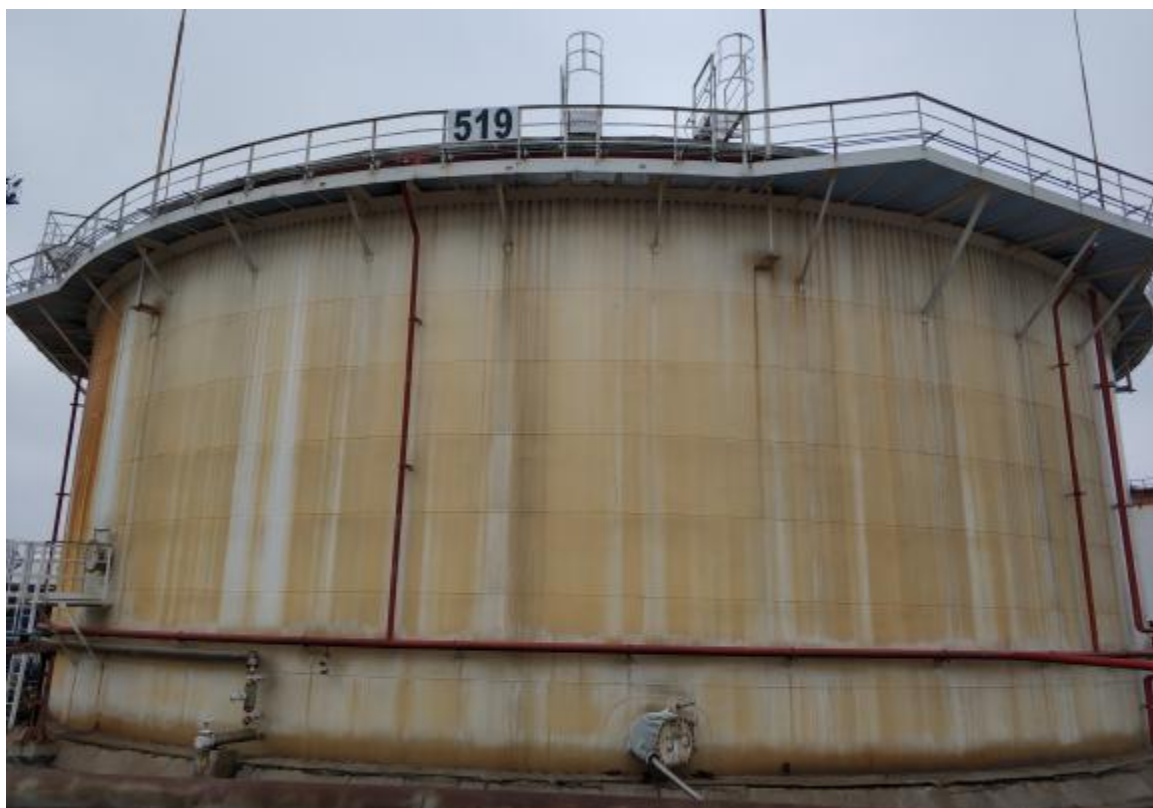
Рисунок 1 – Общий вид резервуара РВСП-10000
