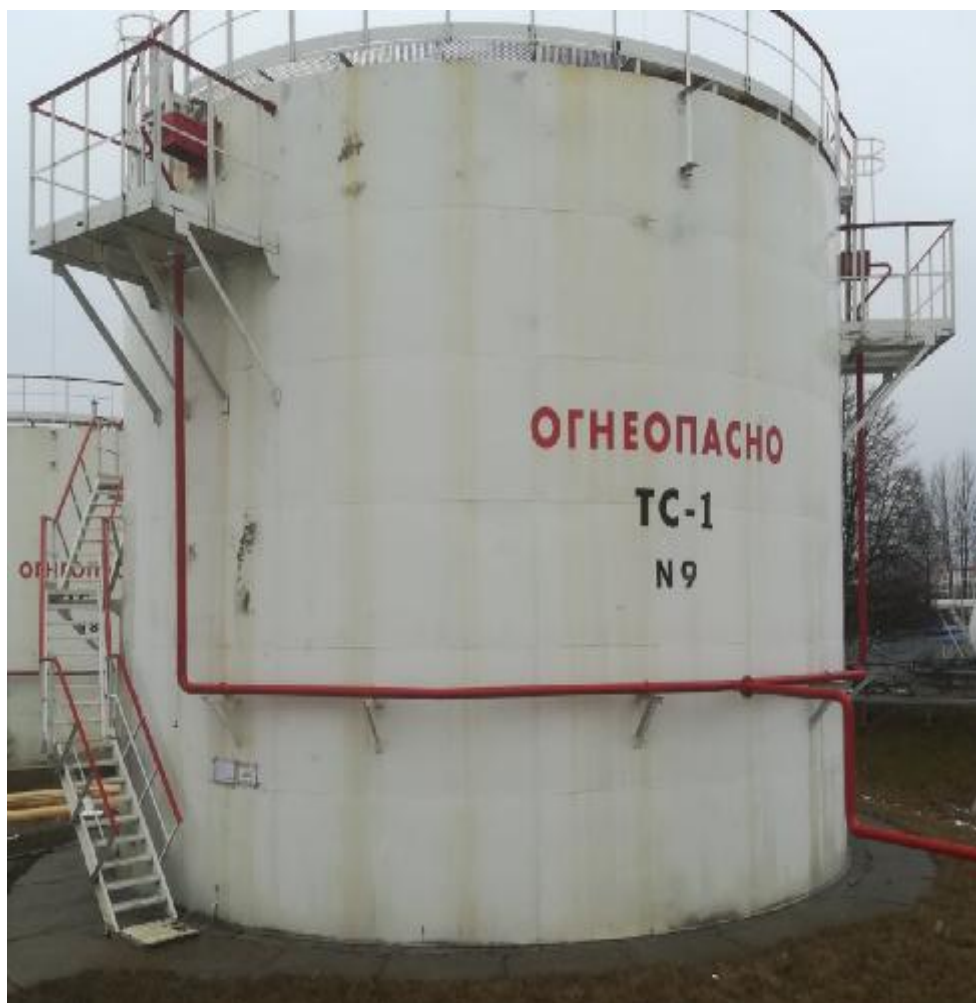
Рисунок 1 – Общий вид резервуара стального вертикального цилиндрического РВС-1000
