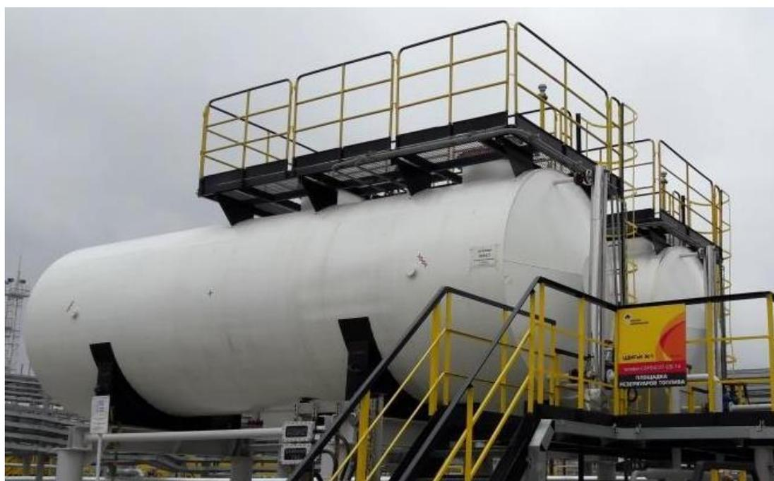
Рисунок 3 – Общий вид резервуара стального горизонтального цилиндрического РГС-50
