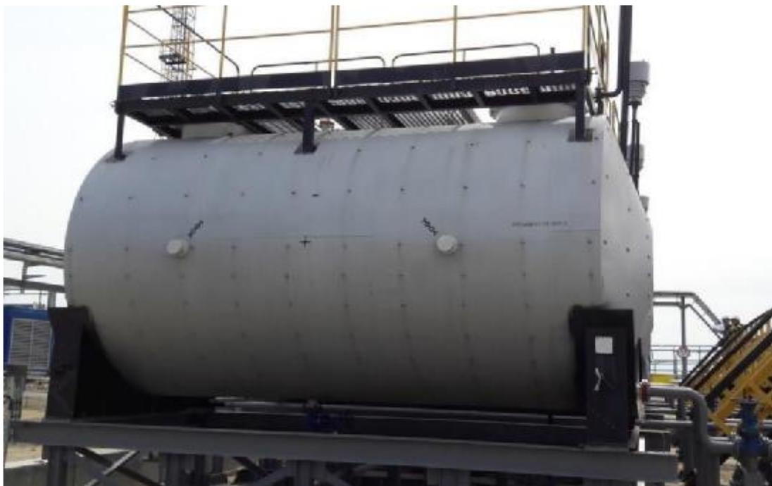
Рисунок 2 – Общий вид резервуара стального горизонтального цилиндрического РГС-25
