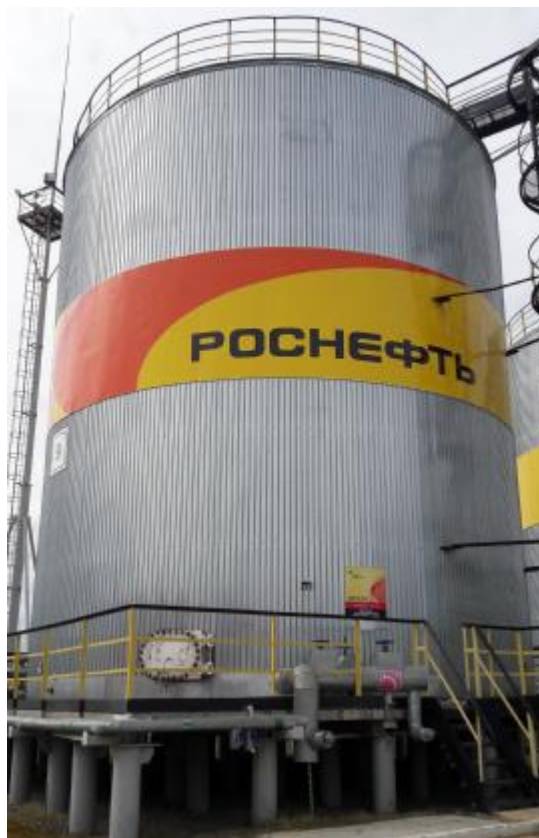
Рисунок 1 – Общий вид резервуара стального вертикального цилиндрического РВС-1000
