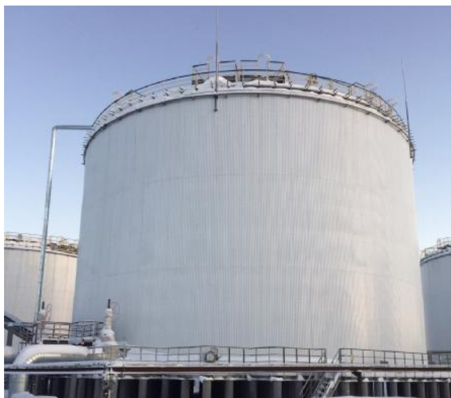
Рисунок 3 – Общий вид резервуара стального вертикального цилиндрического РВС-10000
