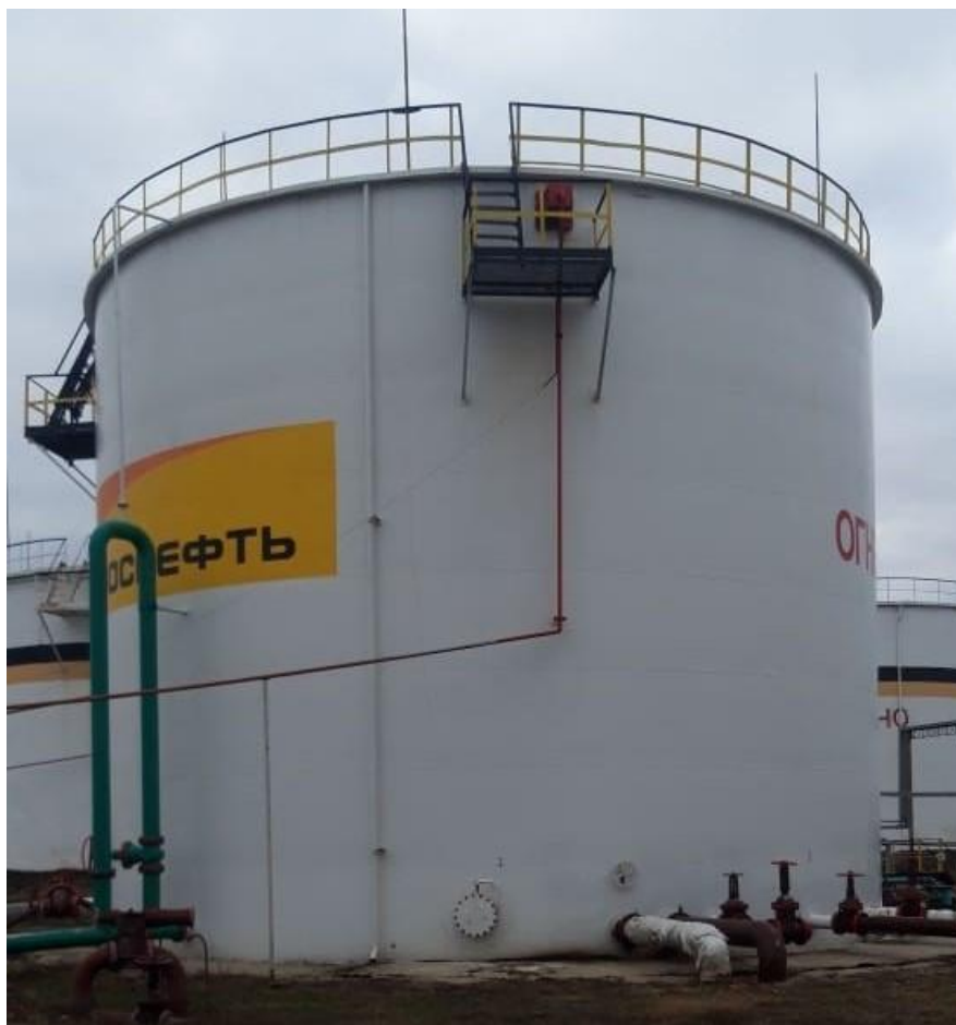
Рисунок 2 – Общий вид резервуаров стальных вертикальных цилиндрических РВС-2000
