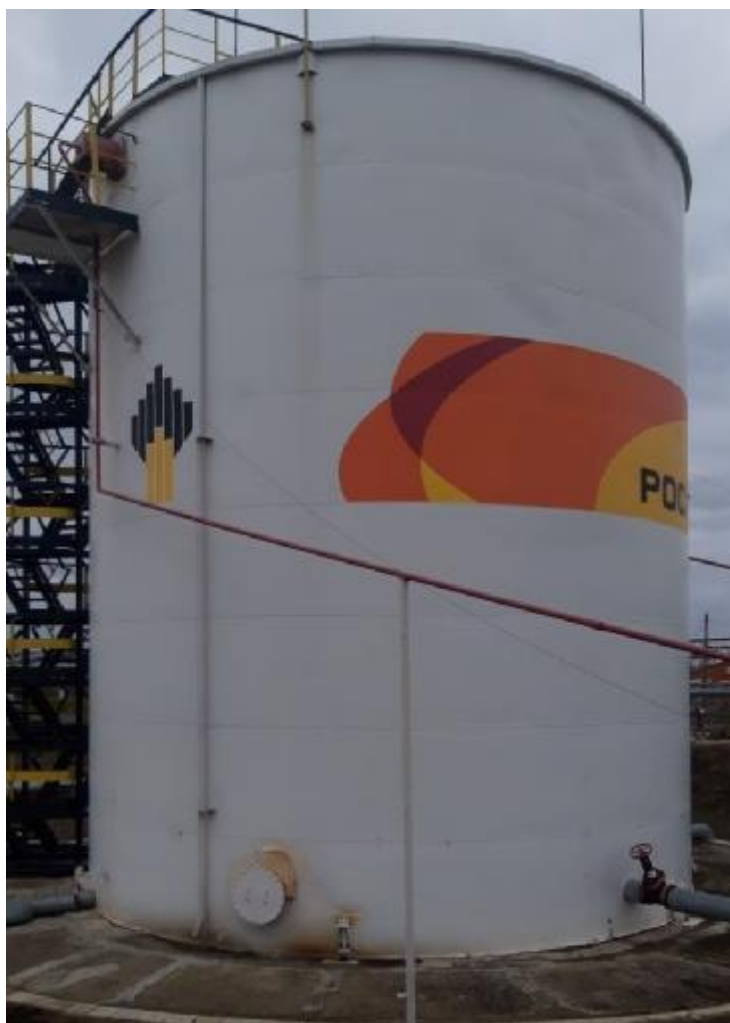
Рисунок 1 – Общий вид резервуаров стальных вертикальных цилиндрических РВС-1000
