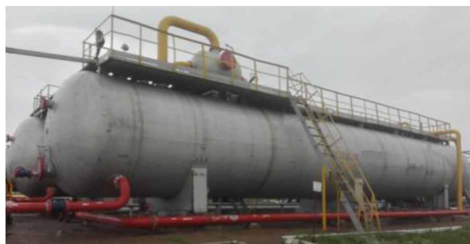
Рисунок 4 – Общий вид резервуаров стальных горизонтальных цилиндрических РГС-200
