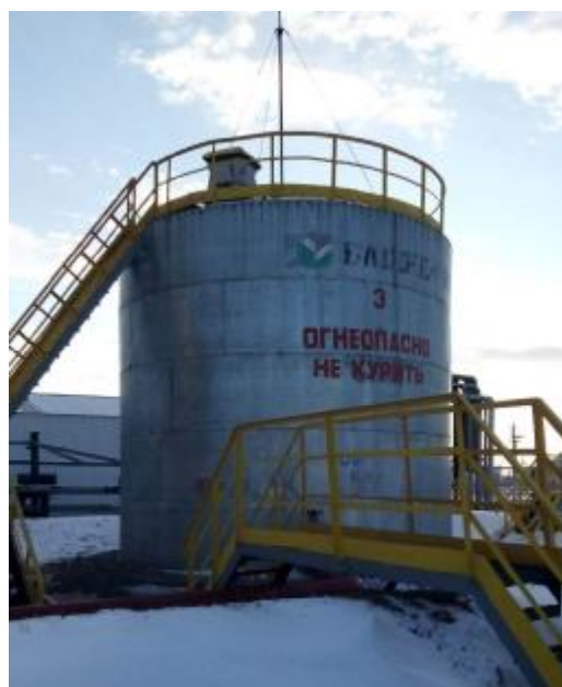
Рисунок 1 – Общий вид резервуара стального вертикального цилиндрического РВС-200
