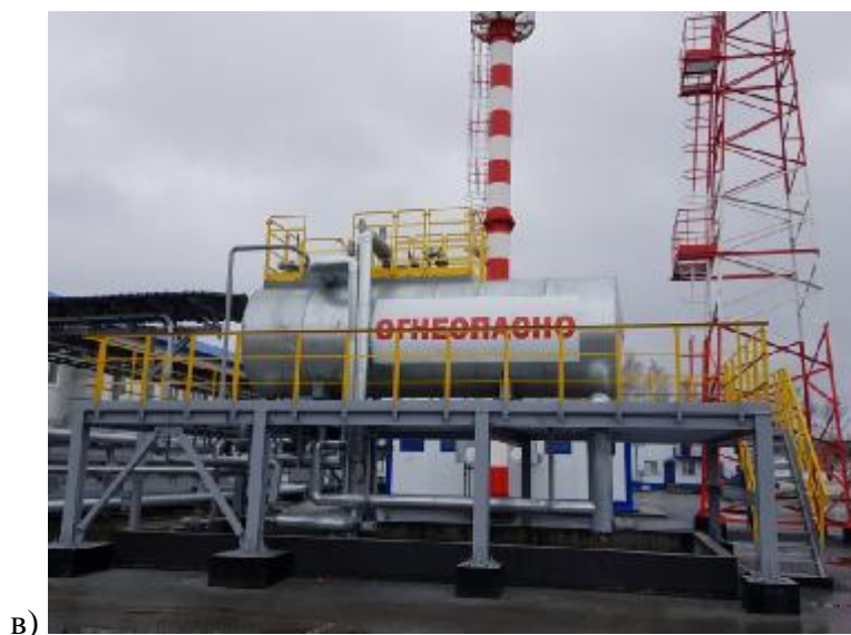
Рисунок 1 – Общий вид резервуаров стальных горизонтальных цилиндрических РГС-20 (17+3) а) зав. № 358, б) зав. № 363, в) зав. № 369
