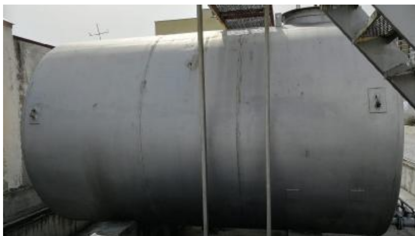
Рисунок 1 – Общий вид резервуара стального горизонтального цилиндрического РГС-25
