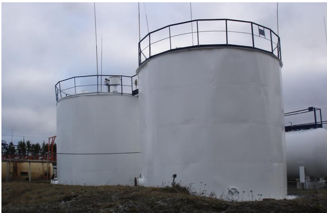
Рисунок 1 – Общий вид резервуаров вертикальных стальных цилиндрических РВС-200
