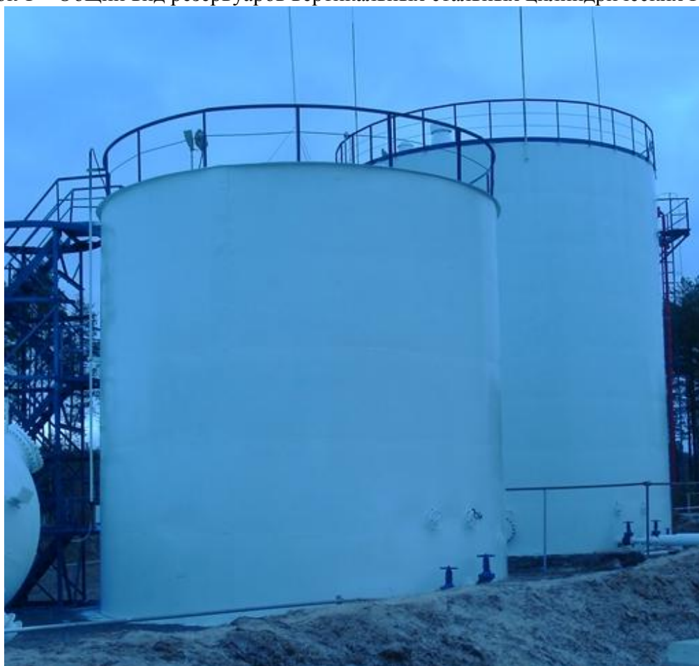
Рисунок 2 – Общий вид резервуара вертикального стального цилиндрического РВС-300
