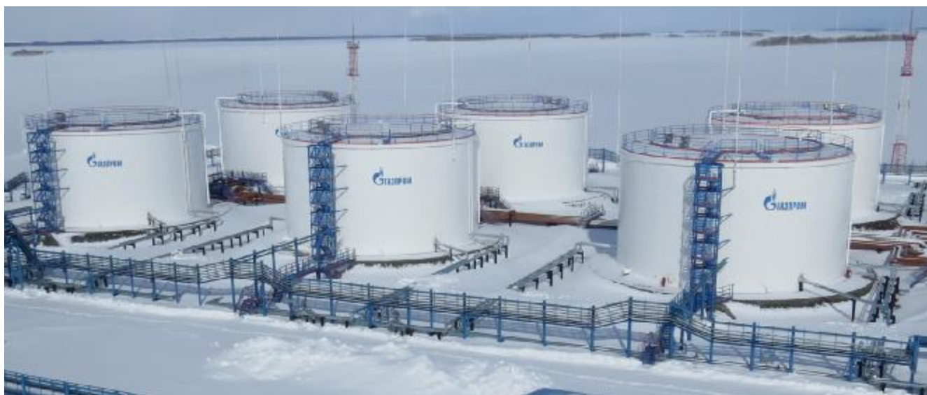
Рисунок 1 – Общий вид резервуаров вертикальных стальных цилиндрических РВС-5000, заводские номера 127, 128, 129, 130, 131, 132
