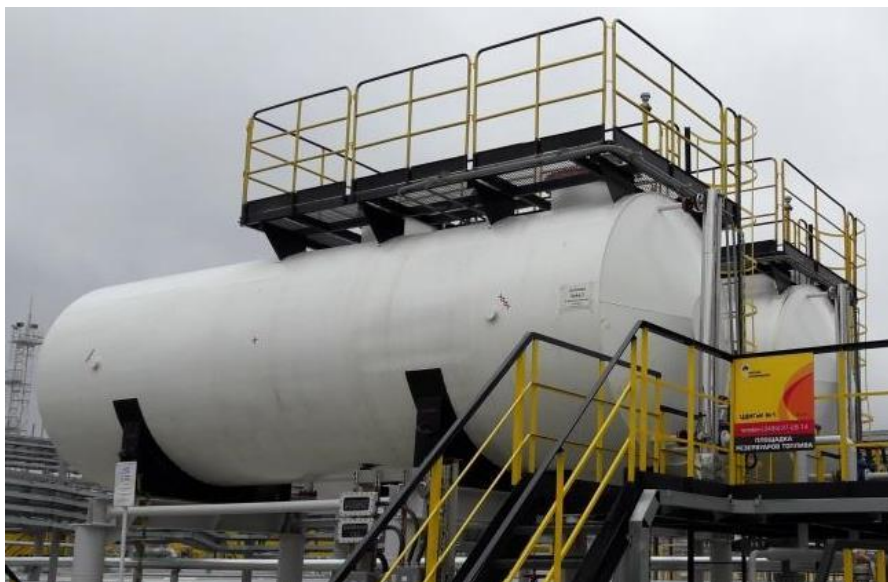
Рисунок 2 – Общий вид резервуара стального горизонтального цилиндрического РГС-50
