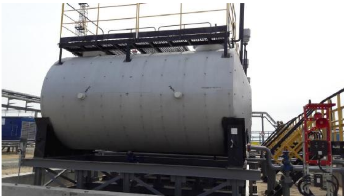
Рисунок 1 – Общий вид резервуара стального горизонтального цилиндрического РГС-25
