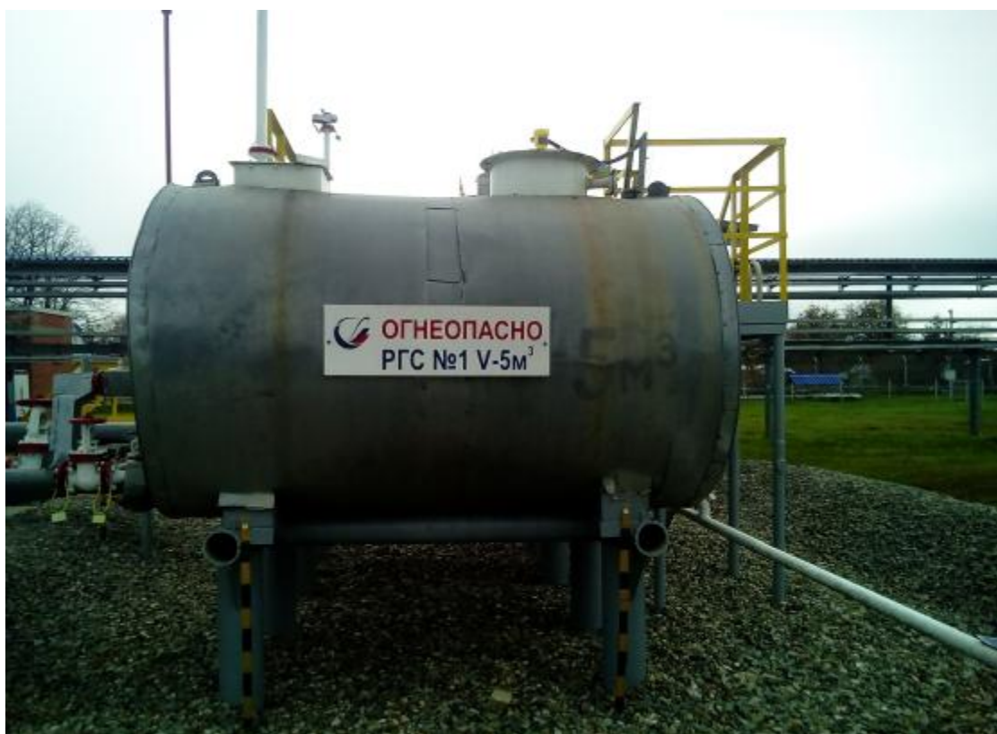
Рисунок 1 – Общий вид резервуара РГС-5, зав. № 134
