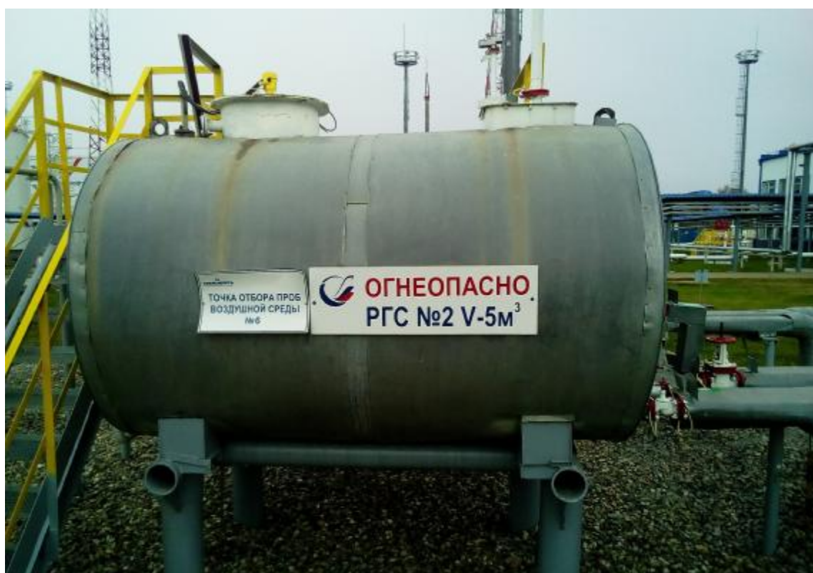
Рисунок 2 – Общий вид резервуара РГС-5, зав. № 137
