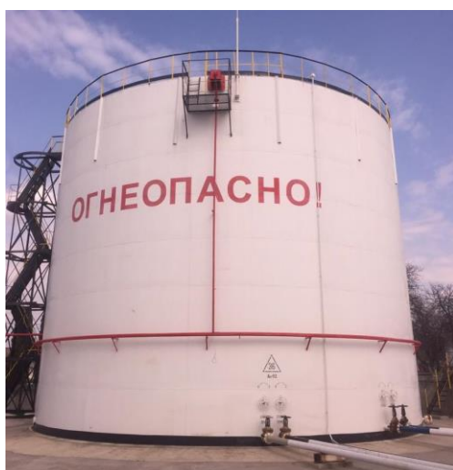
Рисунок 4 – Общий вид резервуаров стальных вертикальных цилиндрических РВС-2000
