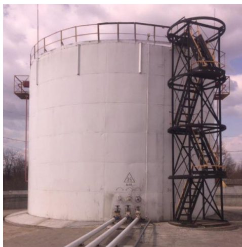
Рисунок 3 – Общий вид резервуаров стальных вертикальных цилиндрических РВС-1000
