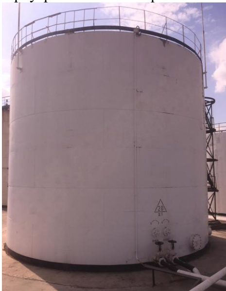
Рисунок 2 – Общий вид резервуаров стальных вертикальных цилиндрических РВС-700
